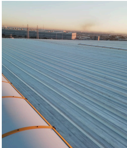
CIUDAD JUAREZ INSTALACION DE KR-18 Y DOMO DE POLICARBONATO
