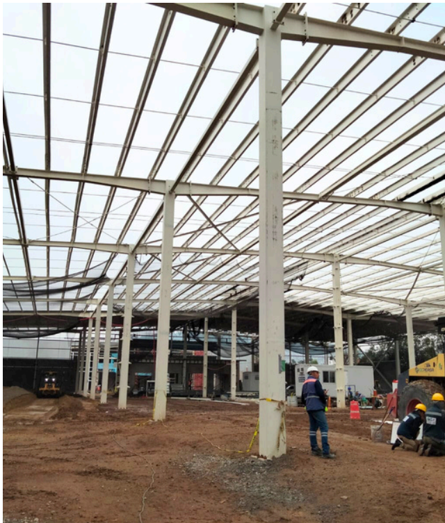
MONTAJE DE ESTRUCTURA BARCEL TOLUCA
