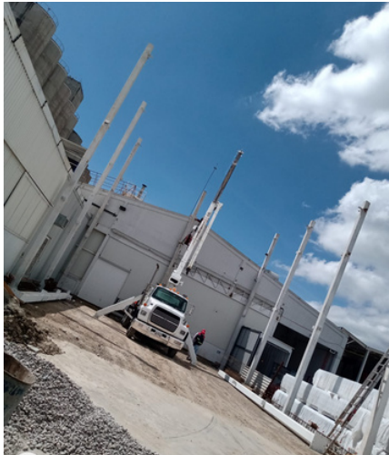
BARCEL LERMA FABRICACION Y MONTAJE DE ESTRUCTURA
