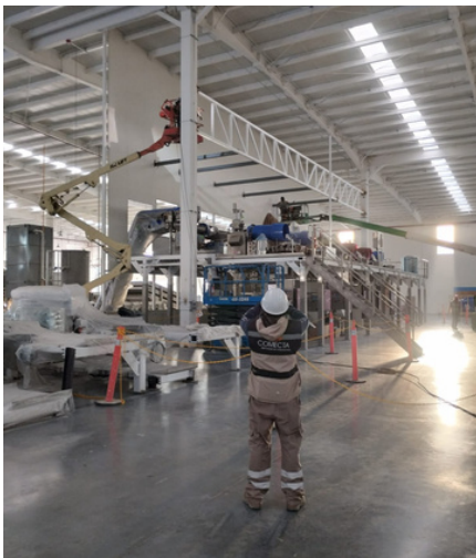
MONTAJE ESTRUCTURA Y PANEL
