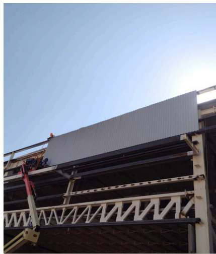
APLICACIÓN DE LÁMNA EN MURO
