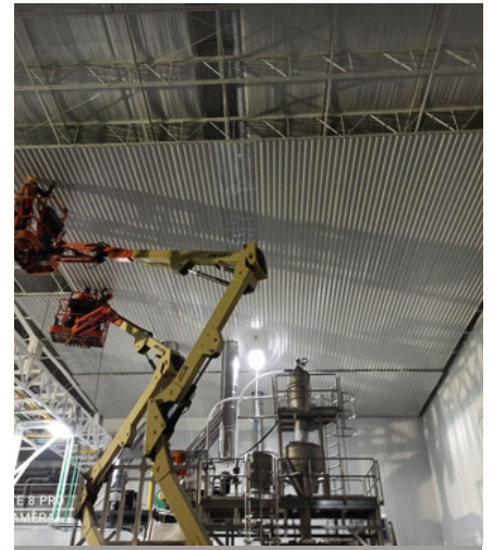
BARCEL MONTERREY ( suministro e instalación plafón de R-101)
