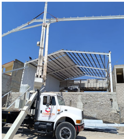
FABRICACION Y MONTAJE DE ESTRUCTURA
