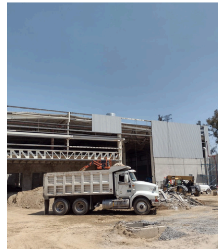
APLICACIÓN DE LÁMNA EN MURO
